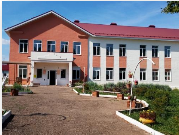
МБОУ «Шеланговская СОШ» (капитальный ремонт)
